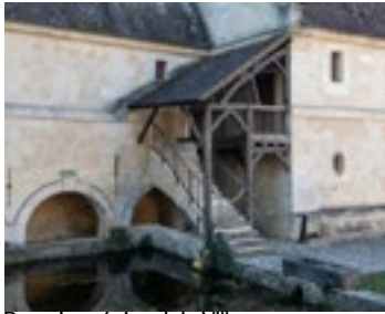
Domaine régional de Villarceaux Escalier bois communs © Photo : Philippe Ayrault- 2021
